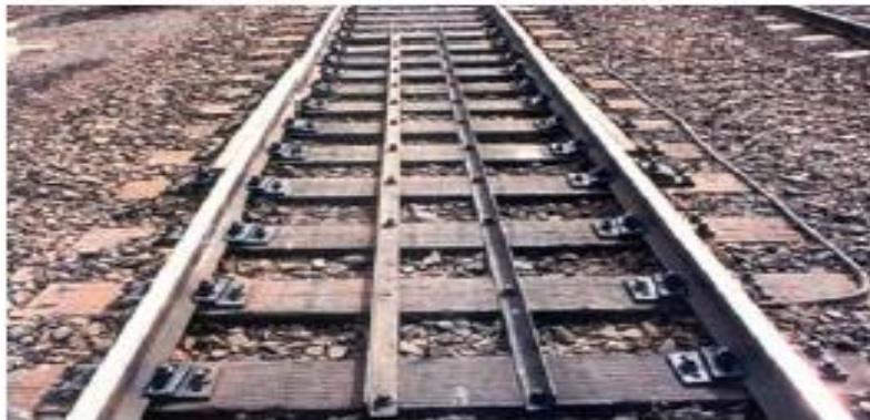
(c) 신축이음매 (expansion joint) - 용접한 장대레일의 단부에 사용
