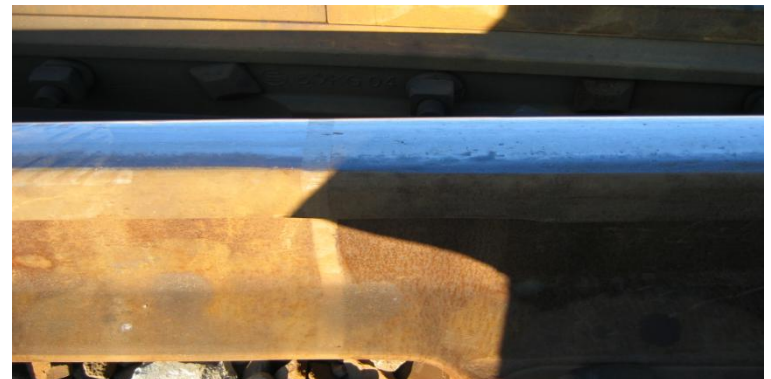
(d) 용접이음매 (welding joint) - 용접하여 외관상으로 이음매가 없음
