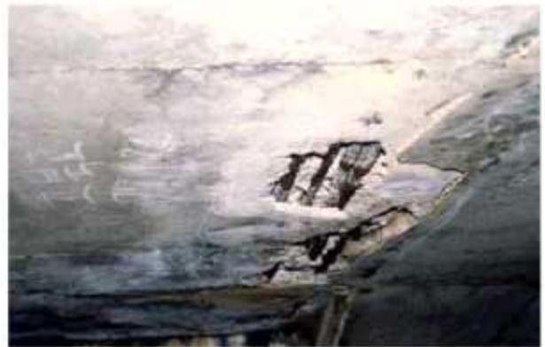
b. 콘크리트 박락, 철근부식 및 노출
