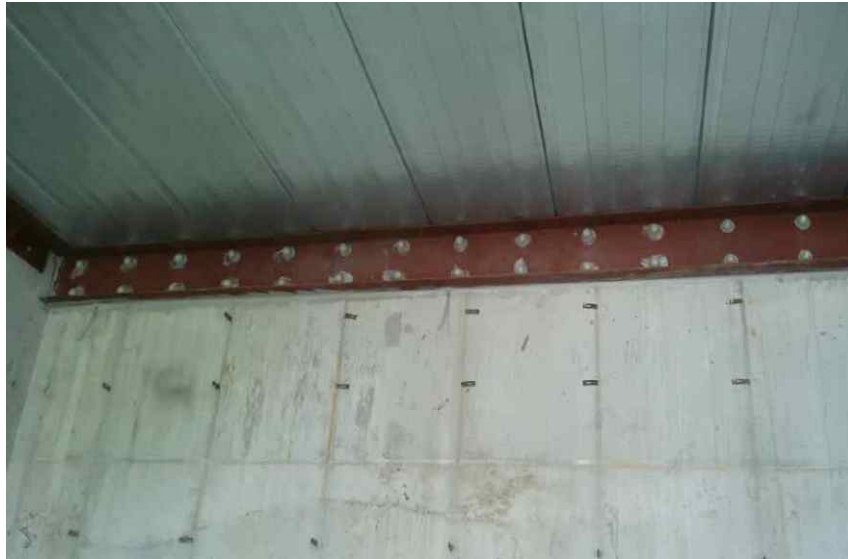
[그림 ] 부재 증설 보강(예시)
