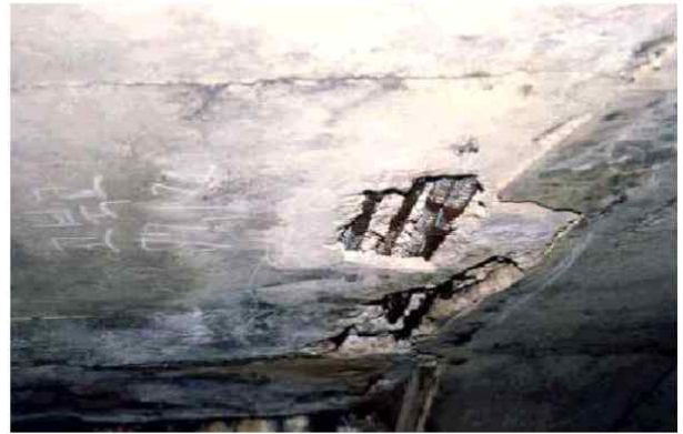
b. 콘크리트 박락, 철근부식 및 노출
