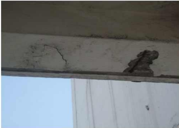
철근부식 의한 콘크리트 박락
