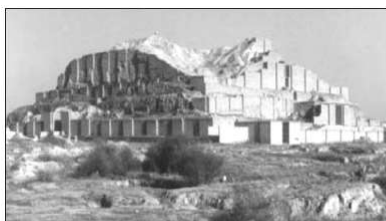
그림 2.2 보강토를 이용한 지구라트 사탑(장범수, 2011)
